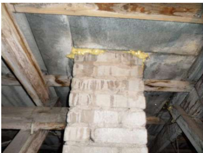
att nr. 25.,26. Neblīvi savienojumi un spraugas jumta segumā.
