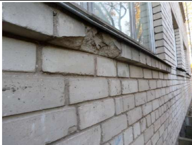
att nr. 12.,13. Nesošajās ķieģeļu sienās vietām plaisas, ķieģeļu, javas izdrupumi.
