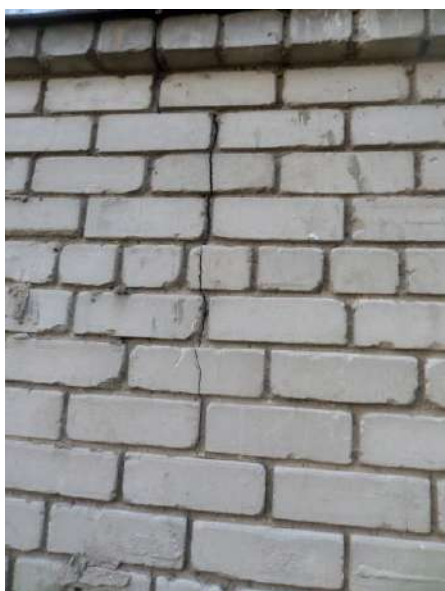
att nr. 14.,15.,16. Nesošajās ķieģeļu sienās vietām plaisas, ķieģeļu, javas
