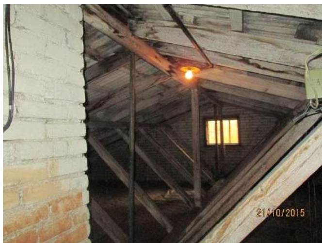
att nr. 23.,24. Uz jumta nesošajām konstrukcijām novēroja mitruma ietekmi.
