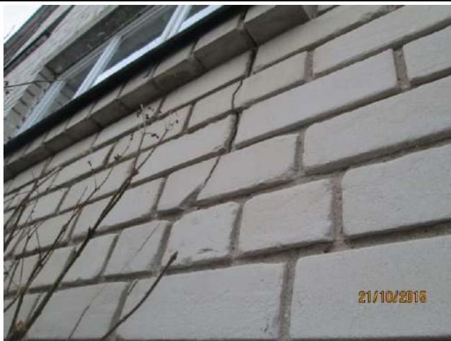
att nr. 12.,13. Nesošajās ķieģeļu sienās vietām plaisas, ķieģeļu, javas izdrupumi.
