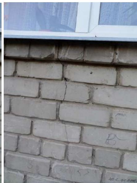
att nr. 14.,15.,16. Nesošajās ķieģeļu sienās vietām plaisas, ķieģeļu, javas
