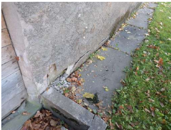
att nr. 07.,08. Cokolam atdalījies apmetums, tas saplaisājis. Betona apmale, cokols apsūņojis. Apmalē spraugas, apmale iebrukusi.
