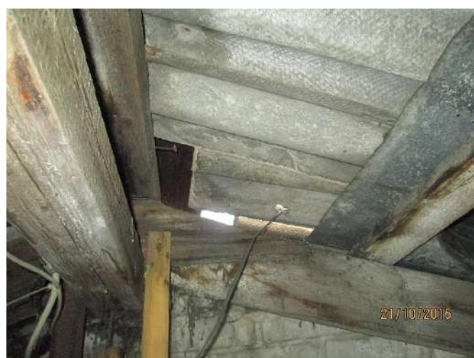
att nr. 25.,26. Neblīvi savienojumi un spraugas jumta segumā.
