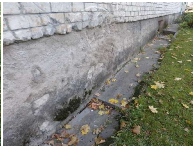
att nr. 07.,08. Cokolam atdalījies apmetums, tas saplaisājis. Betona apmale, cokols apsūņojis. Apmalē spraugas, apmale iebrukusi.
