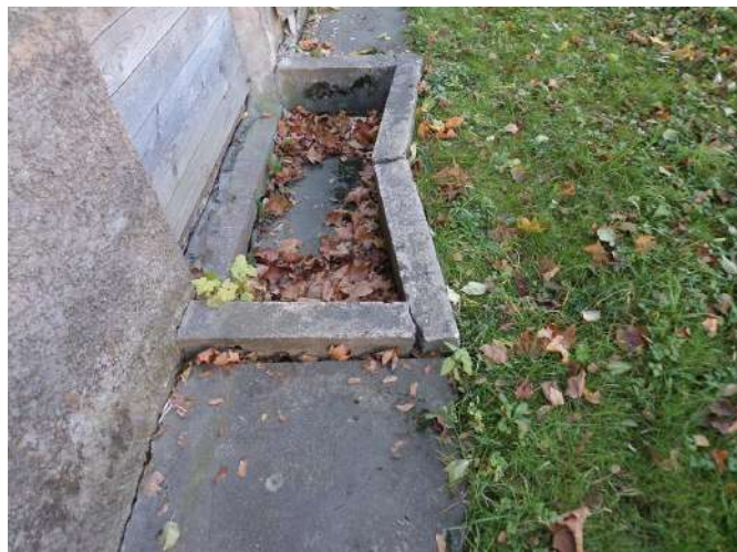
att nr. 05.,06.. Betona apmale apsūņojusi, saplaisājusi. Gaismas akas sienīņa iebrukusi.
