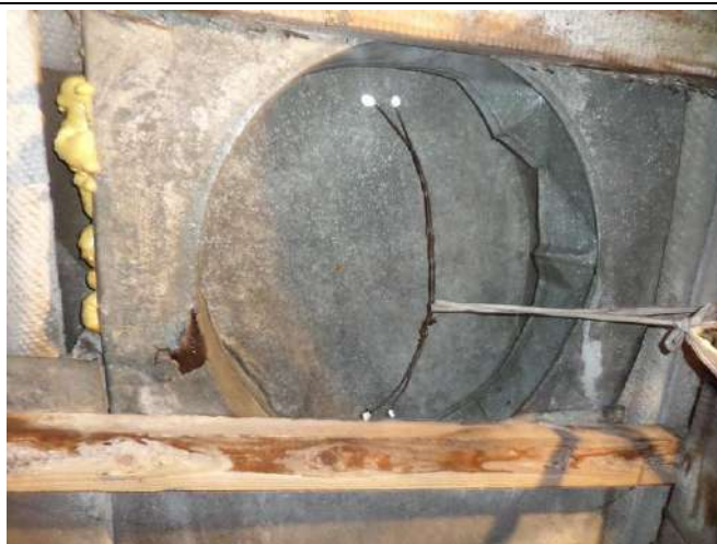
att nr. 27.,28. Jumta lūka. Mitruma radīti bojājumi uz jumta nesošajām konstrukcijām
