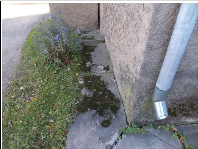
att nr. 05.,06.. Betona apmale apsūņojusi, saplaisājusi. Gaismas akas sienīņa iebrukusi.
