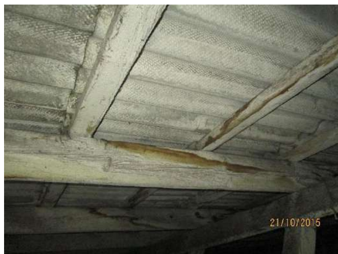
att nr. 23.,24. Uz jumta nesošajām konstrukcijām novēroja mitruma ietekmi.
