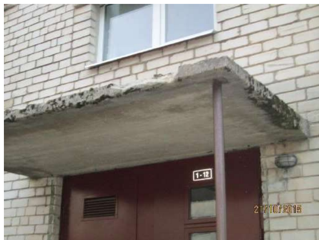
att nr. 27.,28.. Ieejas jumtiņš apsūņojis, tam nav uzbūvēts segums un noseglāseņi.
