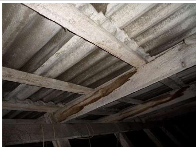
att nr. 27.,28. Jumta lūka. Mitruma radīti bojājumi uz jumta nesošajām konstrukcijām
