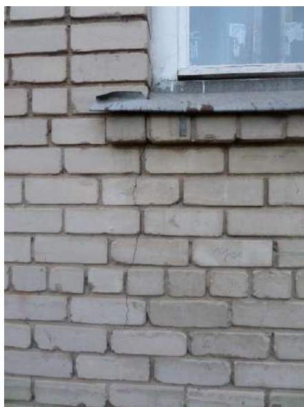
att nr. 14.,15.,16. Nesošajās ķieģeļu sienās vietām plaisas, ķieģeļu, javas
