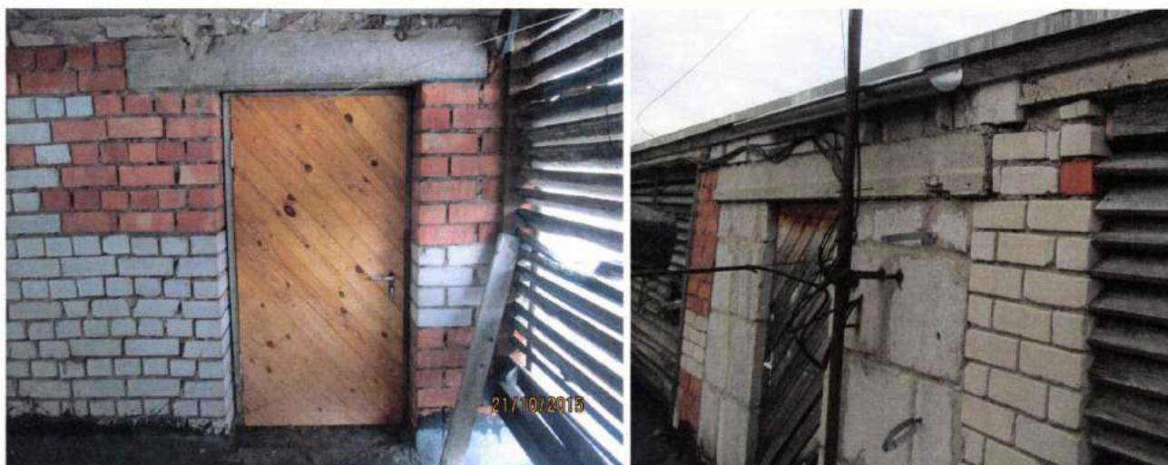
Att. nr. 21.,22. Nesošās sienas veidotas no dažādiem materiāliem, kas nav pietiekoši sajūgti savā starpā.
