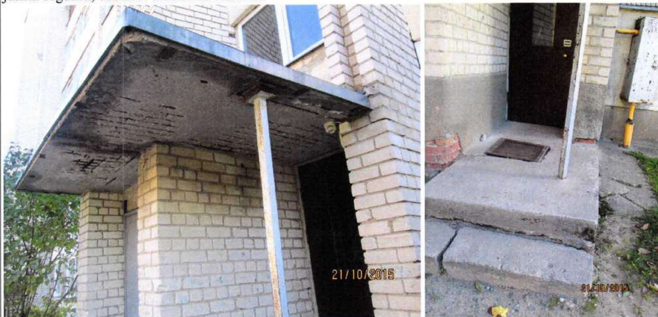
Att. nr. 38.,39. Skārda detaļas korodējušas.
