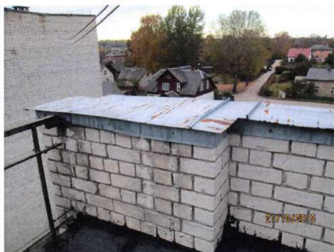
Att. nr. 30.,31. Skārda detaļas korodējušas.
