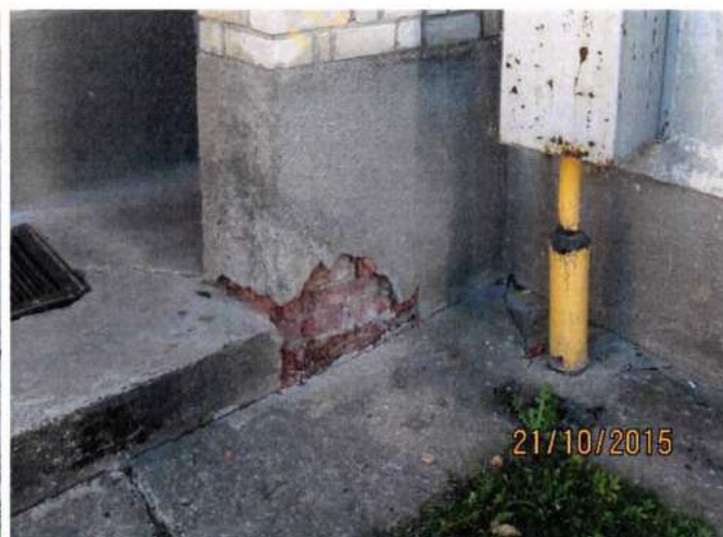
Att. nr. 06., 07. Nodrupis apmetums. Apsūņojusi un deformējusies ēkas aizsargapmale
