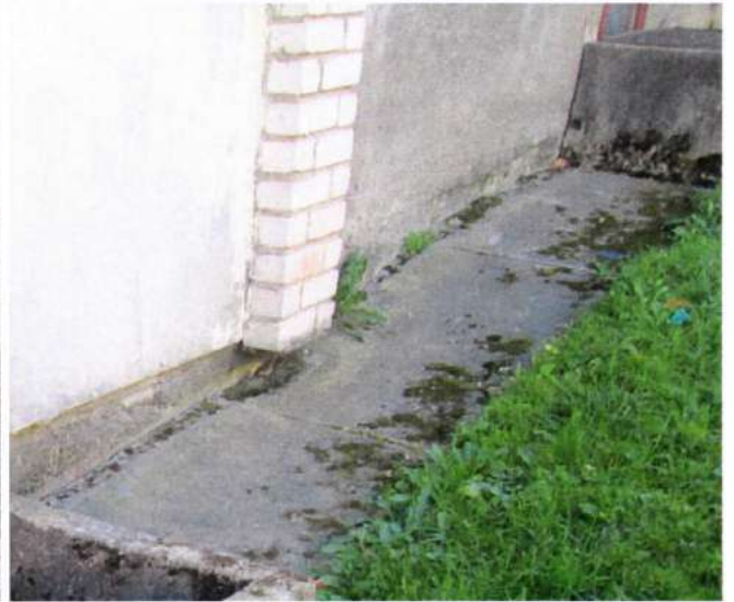
Att. nr. 08.,09. Apsūņojusi un deformējusies ēkas aizsargapmale
