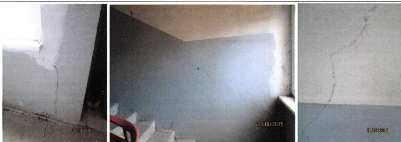
Att. nr. 18.,19.,20. Nesošajās ķieģeļu sienās vietām plaisas (kāpņu telpās).
