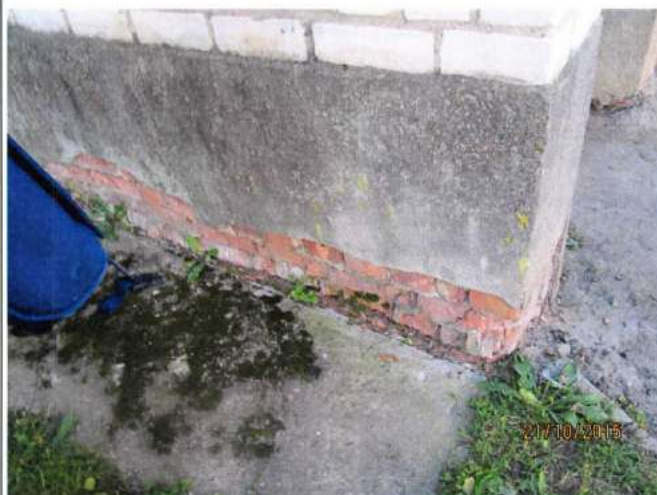
Att. nr. 06., 07. Nodrupis apmetums. Apsūņojusi un deformējusies ēkas aizsargapmale
