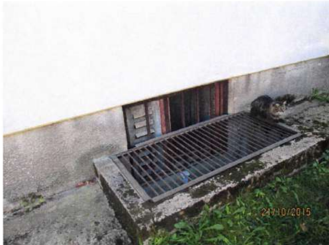
Att. nr. 10.,11. Nodrupis apmetums. Apsūņojusi un deformējusies ēkas aizsargapmale
