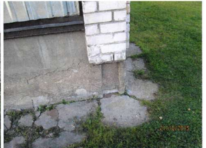
Att. nr. 10.,11. Nodrupis apmetums. Apsūņojusi un deformējusies ēkas aizsargapmale
