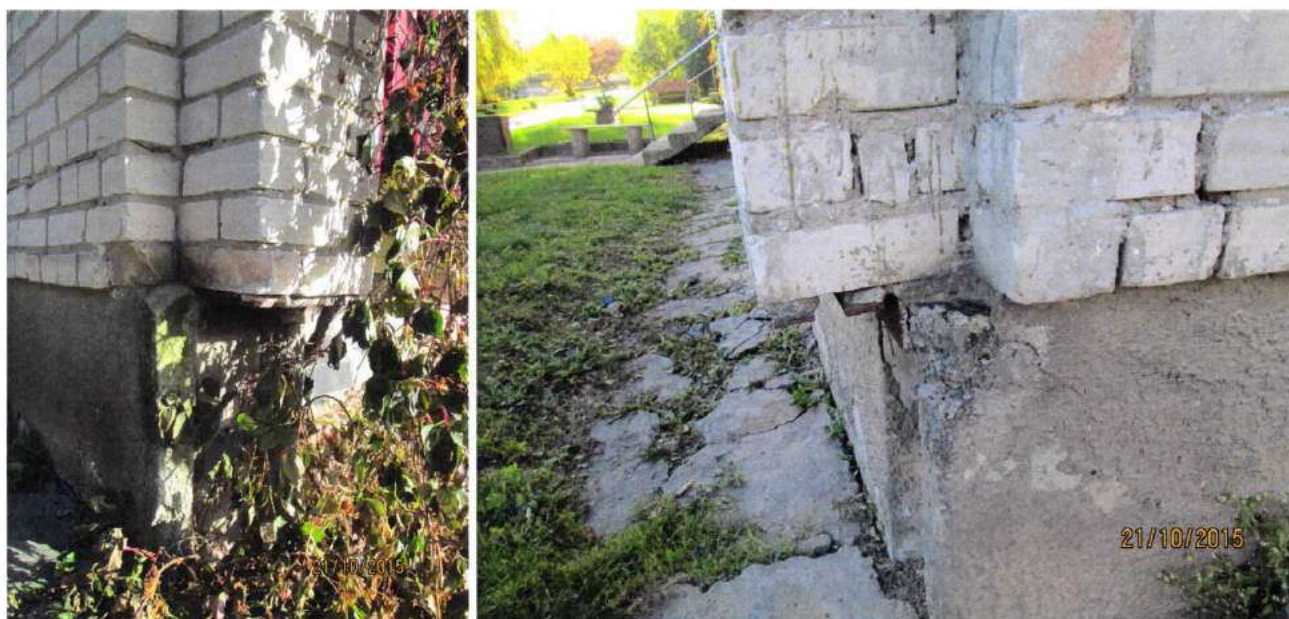
Att. nr. 16.,17. Nesošajās ķieģeļu sienās vietām ķieģeļu, javas izdrupumi. Pilastru galiem nav izbūvēti piemēroti pamati.
