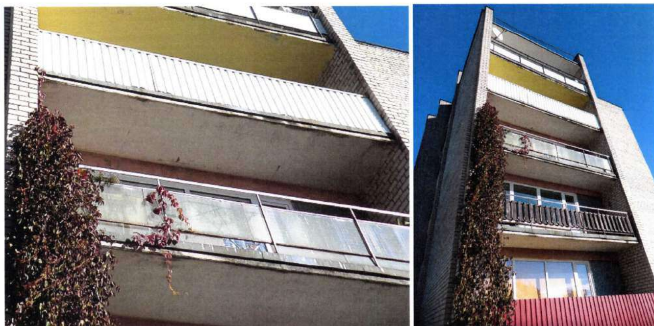
Att. nr. 34.,35. Lodžijas, to apdare, vietām atsegts stiegrojums, betona izdrupumi.
