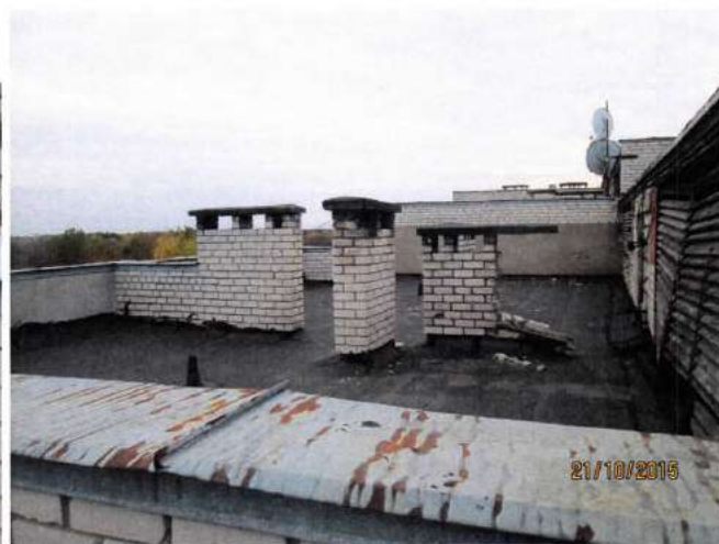
Att. nr. 30.,31. Skārda detaļas korodējušas.
