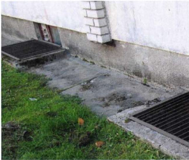
Att. nr. 08.,09. Apsūņojusi un deformējusies ēkas aizsargapmale
