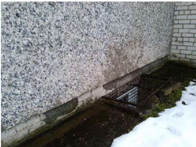
Att. nr. 08., 09. Bojātas gaismas akas, korodējušas, deformētas restes. Nodrupis cokola apmetums.
