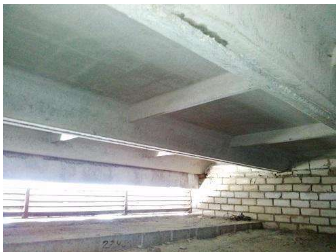
Att. nr. 31., 32. Ribotie pārseguma paneļi no bēniņu puses – vietām vērojami lokāli izdrupumi. Jumts no ārpuses – nav nodrošināta pietiekama hidroizolācija.
