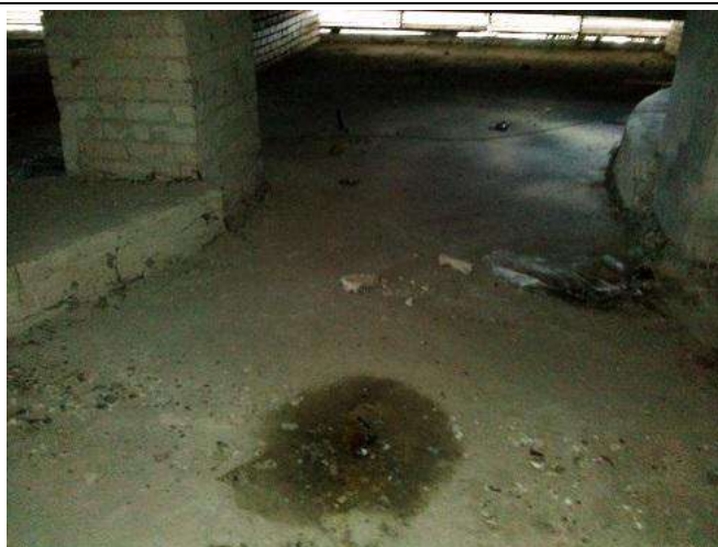
Att. nr. 27., 28. Pagraba pārseguma paneļiem vietām spraugas, izdrupumi. Uz bēniņu pārseguma novērojami mitruma radīti bojājumi.
