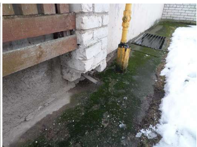
Att. nr. 20., 21. Plaisas, izdrupumi ķieģeļu pilastros. Metāla detaļas korodējušas, deformējušās.
