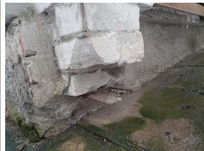
Att. nr. 20., 21. Plaisas, izdrupumi ķieģeļu pilastros. Metāla detaļas korodējušas, deformējušās.
