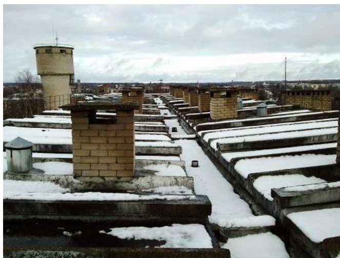
Att. nr. 31., 32. Ribotie pārseguma paneļi no bēniņu puses – vietām vērojami lokāli izdrupumi. Jumts no ārpuses – nav nodrošināta pietiekama hidroizolācija.
