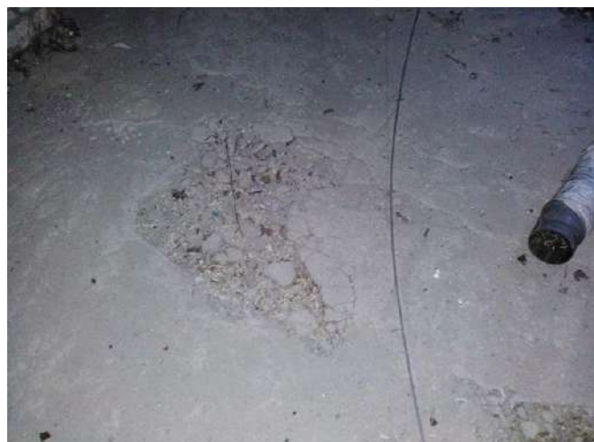
Att. nr. 29., 30. Bēniņu grīdā, pārsegumā virs 1. stāva ieejas vērojami izdrupumi.
