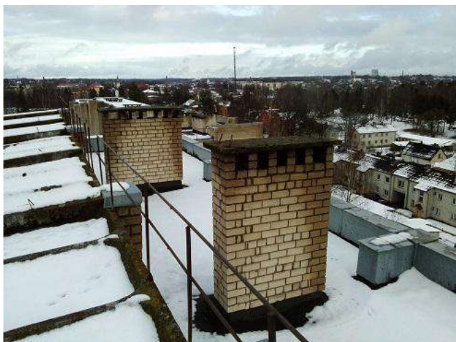
Att. nr. 33., 34. Jumta virs izbīdītās ēkas daļas (4. kāpņu telpa). Ribotie jumta paneļi – vietām novērojami izdrupumi, apsūņojums.
