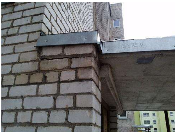
Att. nr. 12., 13.. Plaisas ķieģeļu sienās ap ieejas jumtiņu.
