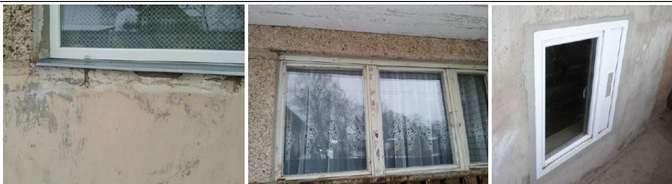
Att. nr. 48., 49., 50. Ēkā esošie PVC, koka logi dzīvokļos. Pagraba PVC logs ar ventilācijas resti.
