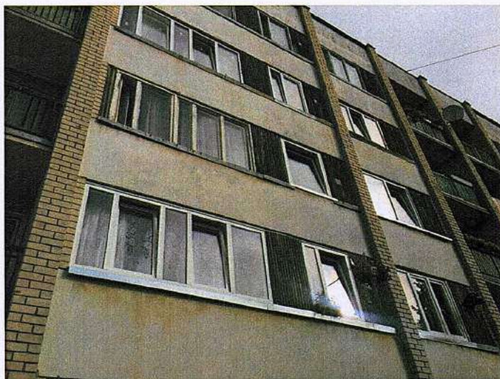
38.att.Nomainītie un nomainītie logi. Nomainot logus nav ievērots to sākotnējais izskats.
