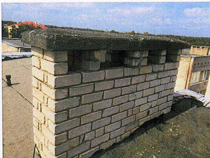
51.att. Ventilācijas šahtu izvadi uz jumta.
