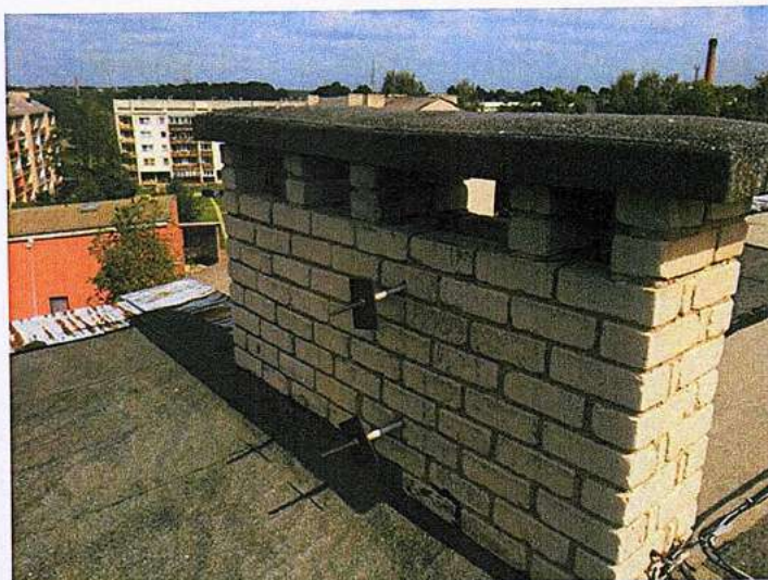
50.att. Ventilācijas šahtu izvadi uz jumta.
