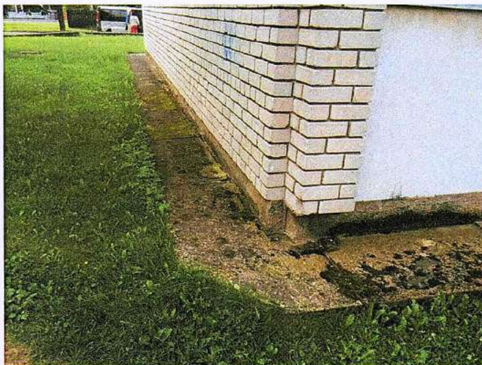
9.att.Ēkas betona apmale.
