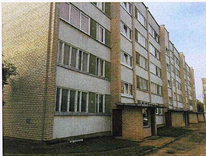
15.att.Ķieģeļu mūra gala sienas un paneļu ārsienas.
