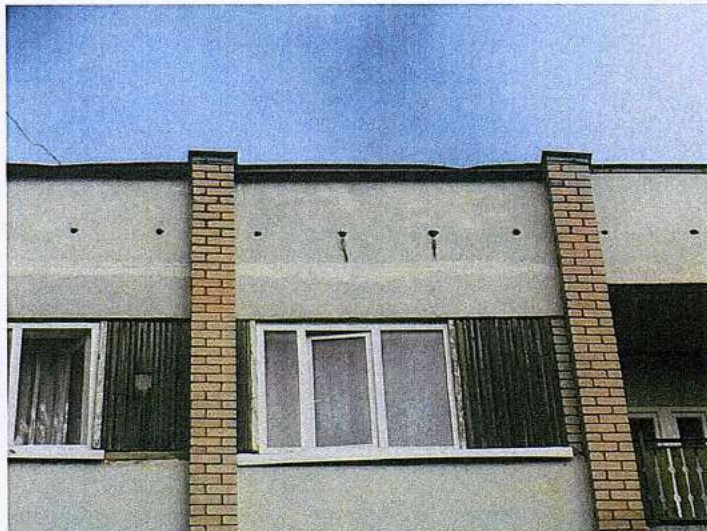
17.att.Ēkai veikta šuvju aizpildījuma atjaunošana.
