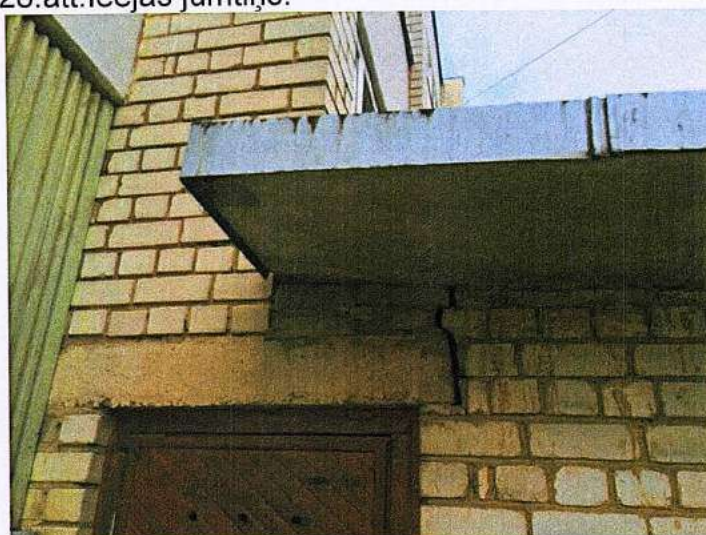
29. Plaisa ķieģeļu mūrī zem ieejas jumtiņa.
