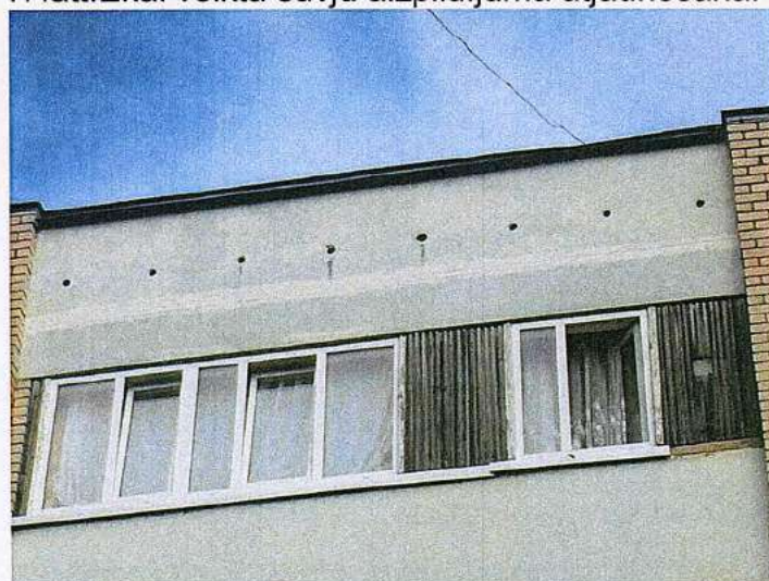
18.att.Ēkai veikta šuvju aizpildījuma atjaunošana..
