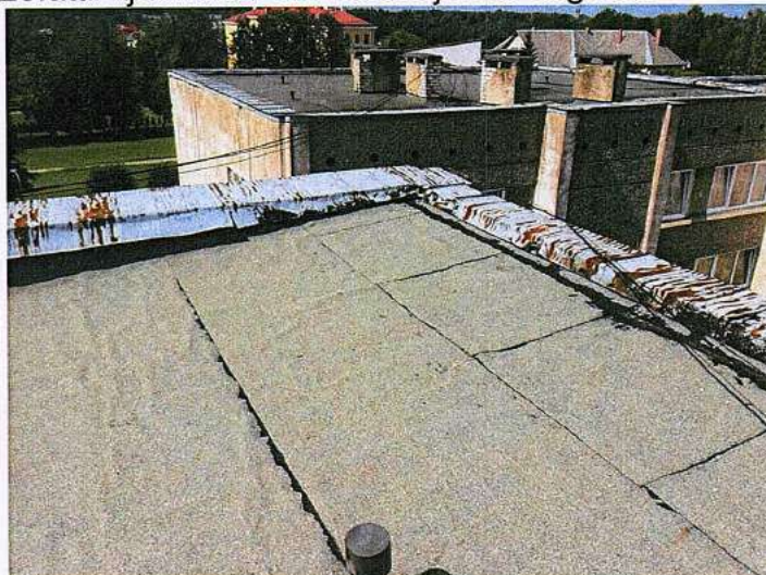
21.att.Atjaunotais ruļļu materiāla jumta segums, sarūsējis parapeta apšuvums.
