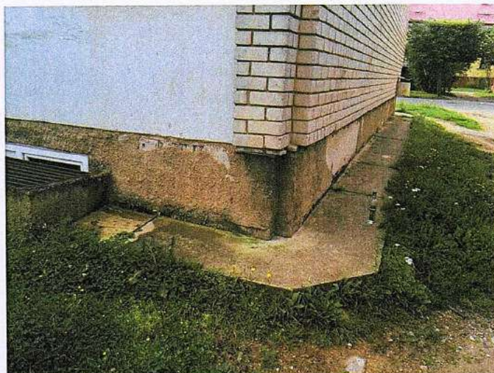
12.att.Ēkas betona apmale.
