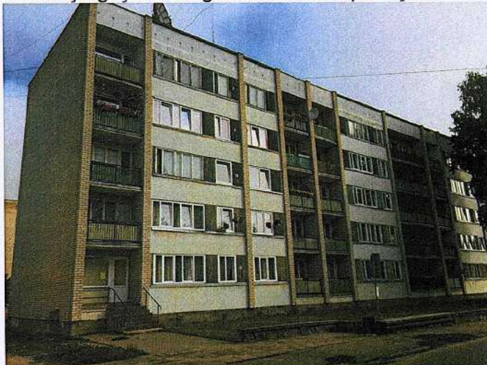
16.att.Ķieģeļu mūra gala sienas un paneļu ārsienas.
