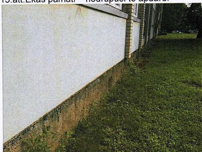
14.att.Horizontalās hidroizolācijas ieklāšanas vieta..
