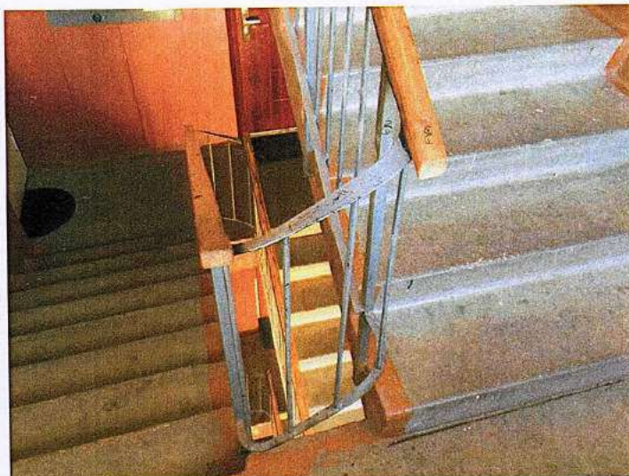
32.att.Kāpņu marga ar roku balstu trūkst neliels balsta posms.
