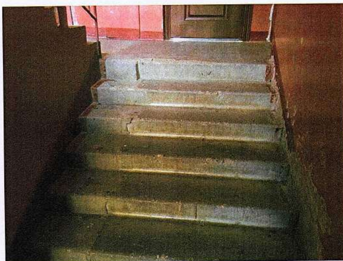
30.att.Kāpnes kāpņutelpā – saliekamie dzelzsbetona kāpņu laidī.
