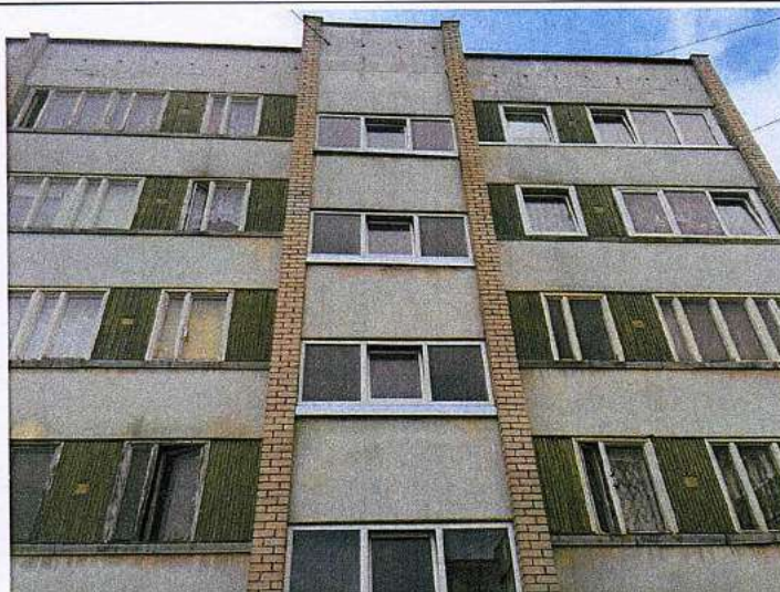
40.att.Nomainītie un nomainītie logi. Kāpņu telpā nomainītie logi. Nomainot logus nav ievērots to sākotnējais izskats.
