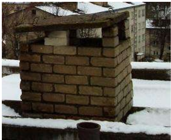
Att. nr. 56., 57. Ventilācijas kanāli virs jumta daļā.
