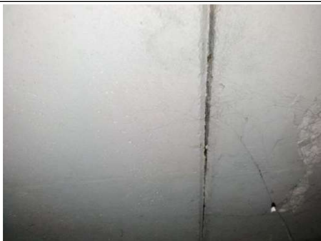
Att. nr. 27., 28. Pagraba pārseguma paneļiem vietām spraugas, izdrupumi. Uz bēniņu pārseguma novērojami mitruma radīti bojājumi.
