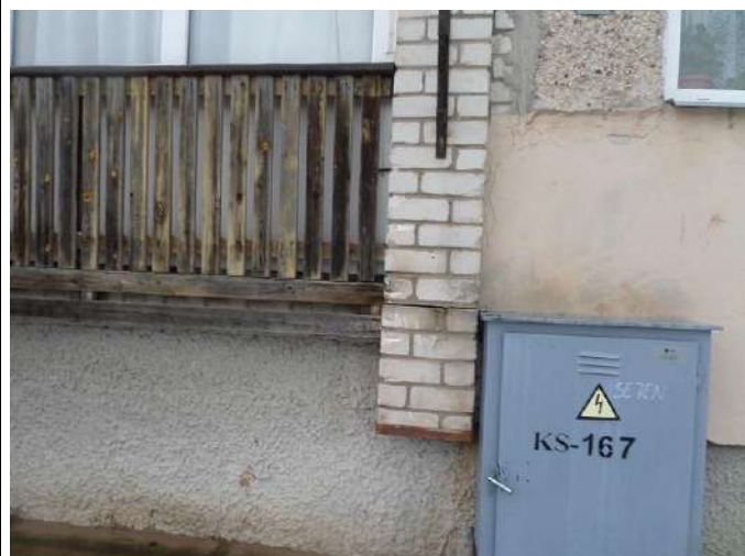
Att. nr. 18., 19. Plaisas ķieģeļu pilastros. Metāla detaļas korodējušas, deformējušās.
