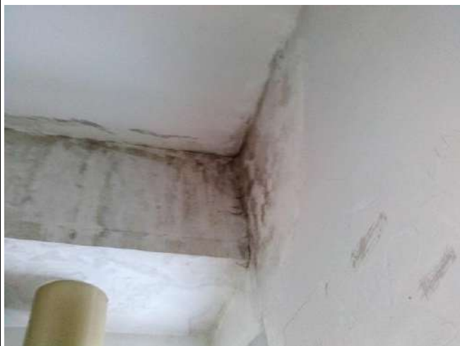
Att. nr. 35. Uz kāpņu telpas griestiem vērojami mitruma radīti bojājumi, kas liecina par nepietiekamu jumta hidroizolāciju.
