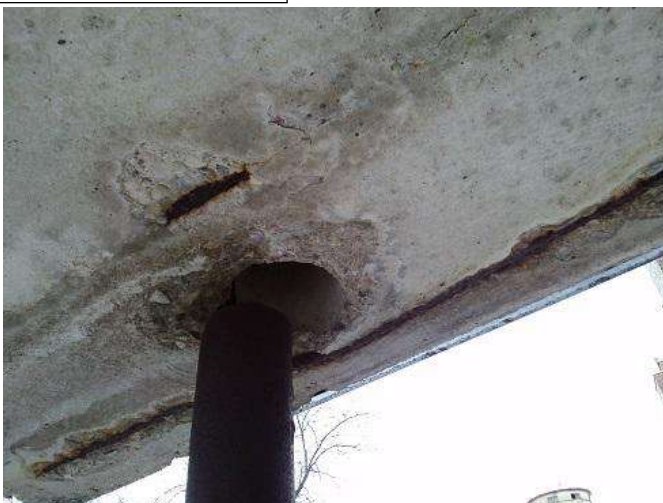
Att. nr. 38., 39. Ieejas jumtiņi - atsegts stiegrojums, betona izdrupumi, vietām starp jumtiņu un kolonnu sprauga.
