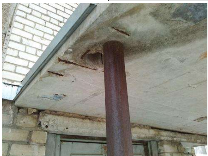
Att. nr. 38., 39. Ieejas jumtiņi - atsegts stiegrojums, betona izdrupumi, vietām starp jumtiņu un kolonnu sprauga.
