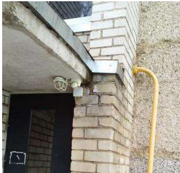
Att. nr. 12., 13.. Plaisas ķieģeļu sienās ap ieejas jumtiņu.
