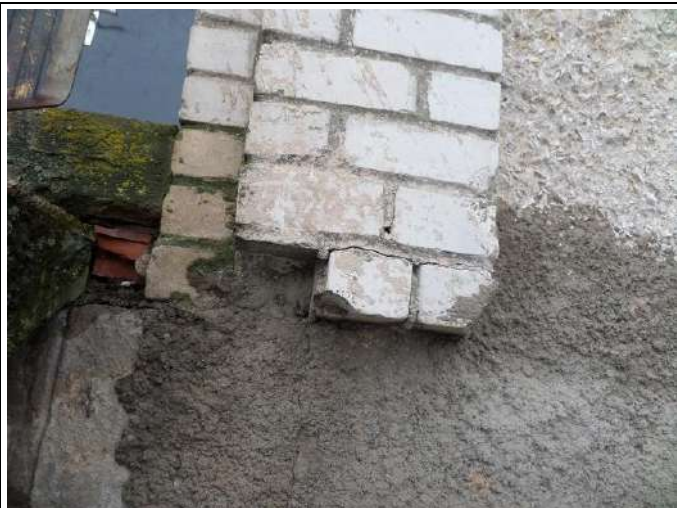
Att. nr. 16., 17. Plaisas, izdrupumi ķieģeļu pilastros. Metāla detaļas korodējušas, deformējušās.
