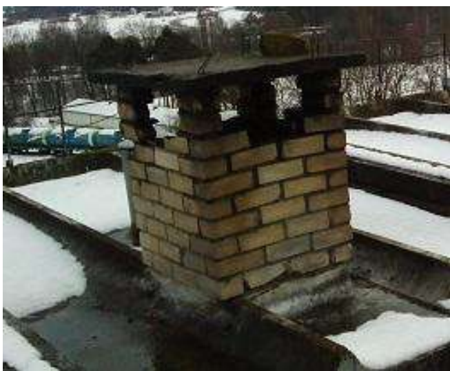
Att. nr. 56., 57. Ventilācijas kanāli virs jumta daļā.
