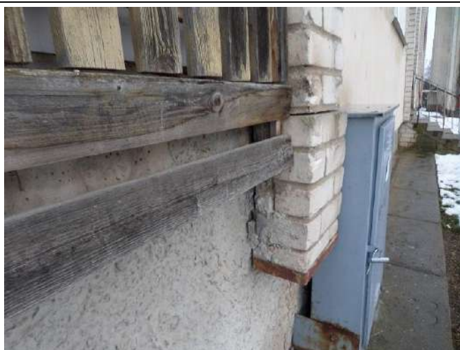
Att. nr. 16., 17. Plaisas, izdrupumi ķieģeļu pilastros. Metāla detaļas korodējušas, deformējušās.
