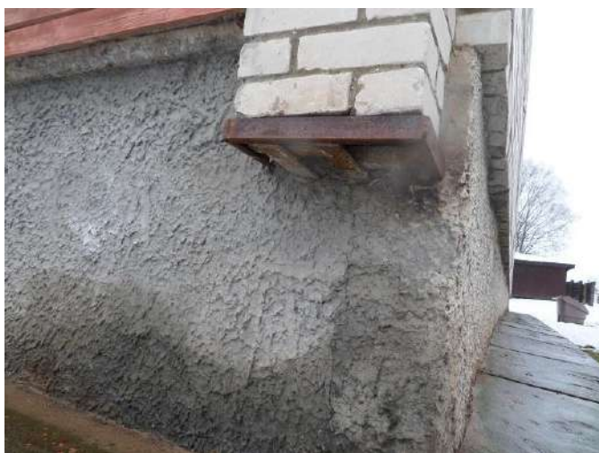
Att. nr. 18., 19. Plaisas ķieģeļu pilastros. Metāla detaļas korodējušas, deformējušās.
