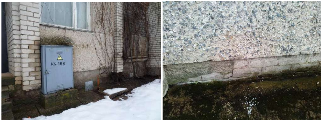
Att. nr. 10., 11. Apmale, cokols apsūņojis. Apmalei nav nodrošināti pareizie slīpumi, vietām tā iebrukusi.
